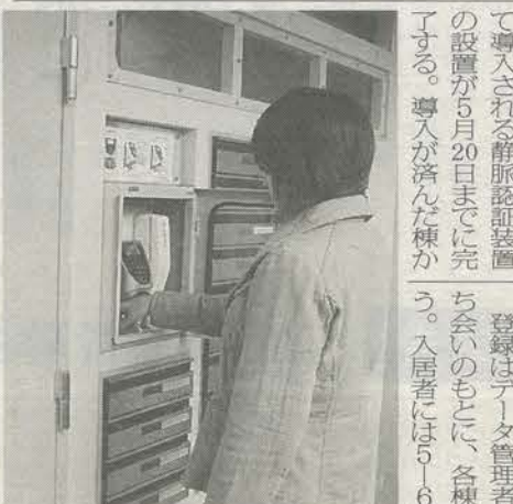
平砂4号棟に導入された静脈認証装置
