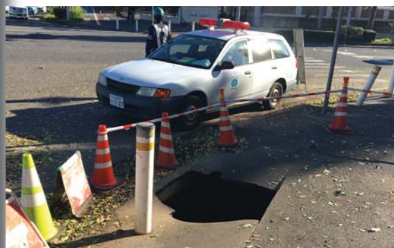
陥没した路面の地中には深さ約4桁の空洞が広がっていた (10月30日、東大通りで) = 田中開 (教育学類4年) 撮影
