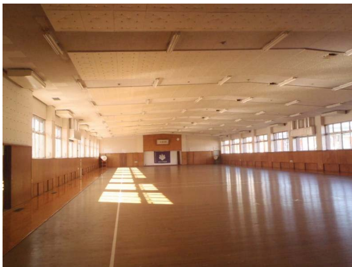
武道場耐震改修(天井)
